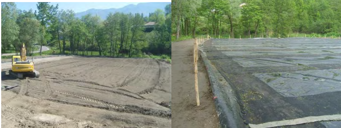
Figure 14 : Concassage bâchage à Viviers-du-Lac [10]
