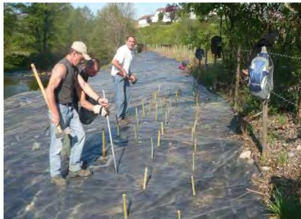
Figure 24 : Installation des 2400 boutures de saules [41]
