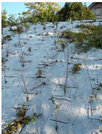
Figure 18 : Détail du géotextile de la friche industrielle des Prés de Vaux à Besançon, parcelle traitée depuis quelques mois [36]
