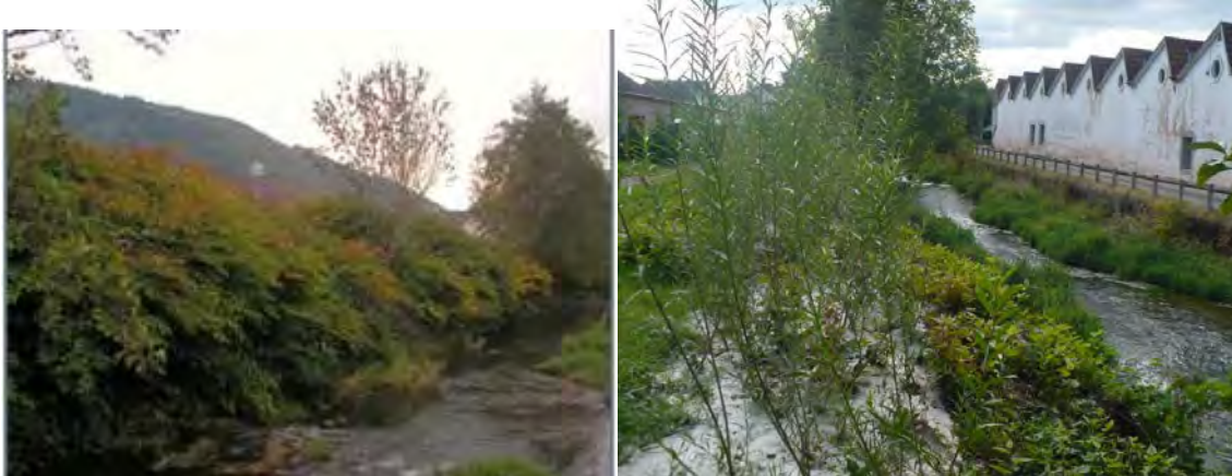
Figure 21 : Berge avant et après pose du géotextile [41]
