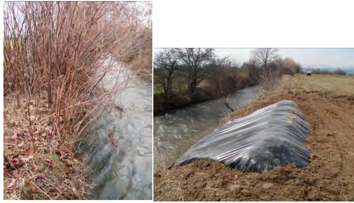
Figure 15 : Bâchage aux Collières à Epinouze [10]
