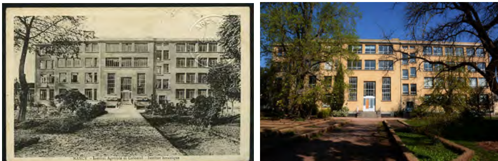
Bâtiment vu du jardin botanique : aspect en 1933 et aspect actuel
