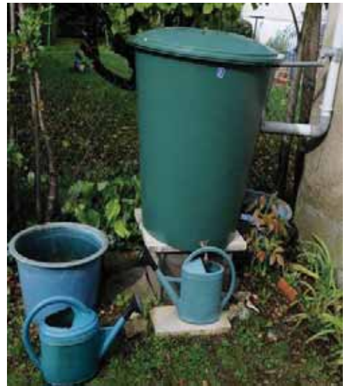
Figure 18 :Récupérateur d'eau de pluie [26]
