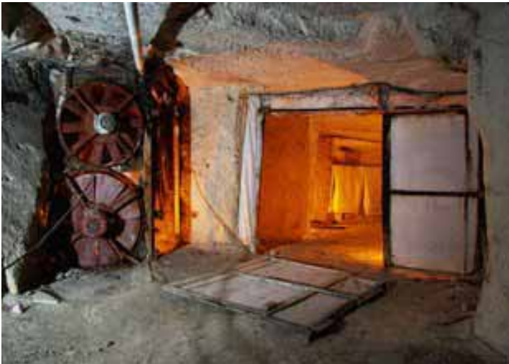
Illustration 5: L'air est soufflée par ces gros ventilateurs , www.troglos.com
