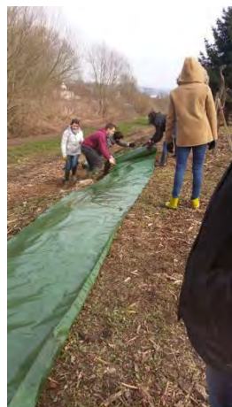
Figure 27 : Pose de la bâche à Belleville
