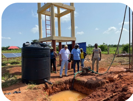
Forage à 60 mètres et pompage via l'énergie solaire pour irrigation en période sèche
